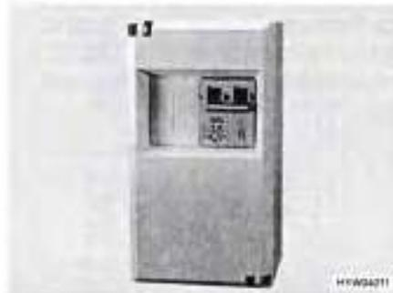
Fig. 128 Coffret de fusibles 230 V avec disjoncteur de protection de circuit et des personnes (FI)
