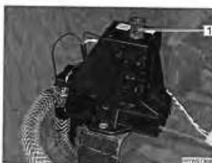
Fig. 152 Valve de sécurité et de vidange du chauffe-eau
