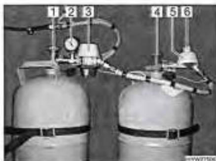
Fig. 113 Dispositif de commutation Duomatic
